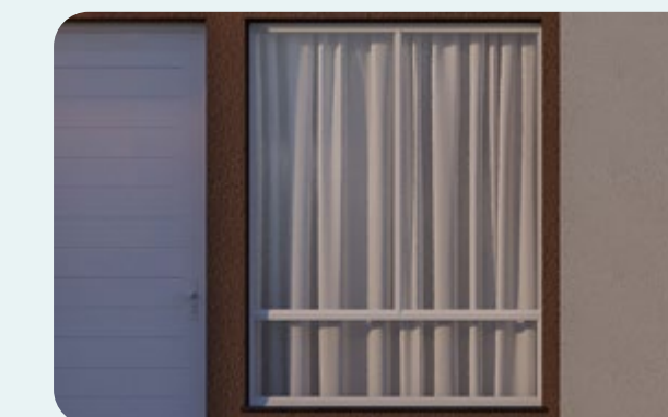
Esquadrias em alumínio com pintura eletrostática
