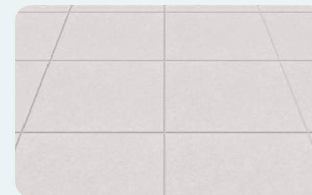
Revestimento cerâmico acima da bancada da cozinha
